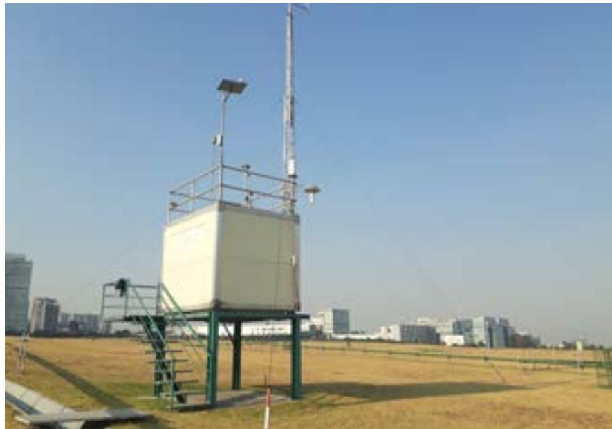
Estación del Sistema de monitoreo atmosférico
