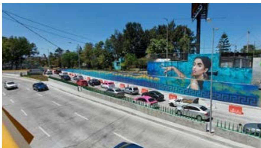
Sobse, puente vehicular Galindo y Villa
