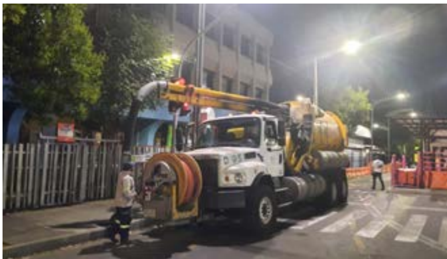
Desazolve Av. Tláhuac
