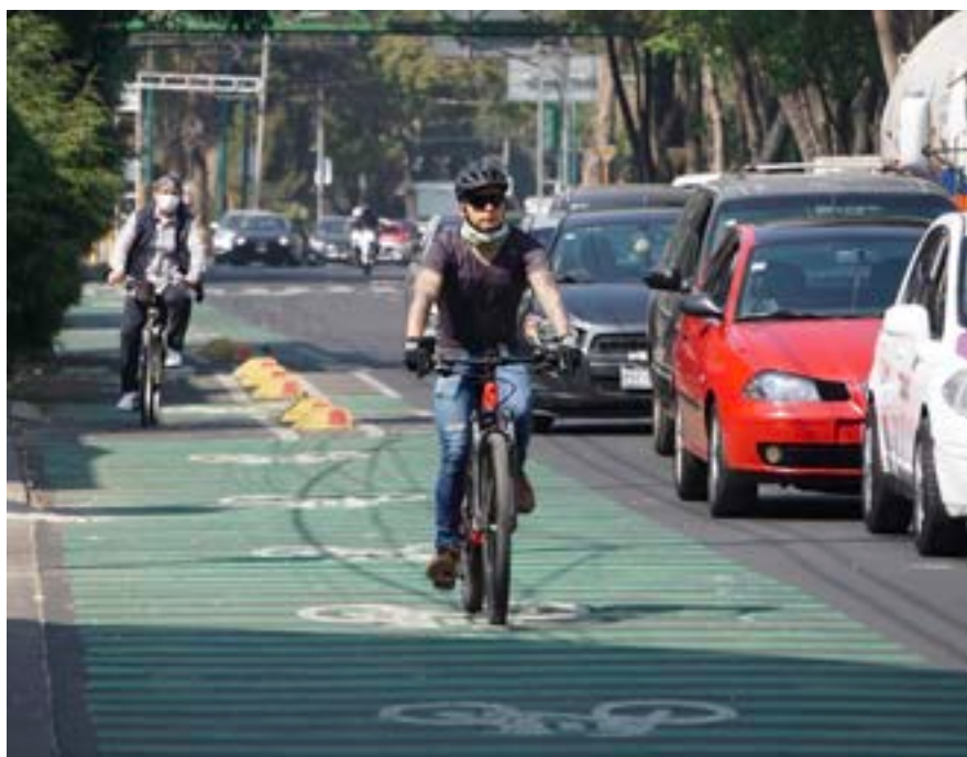
Semovi, Infraestructura ciclista
