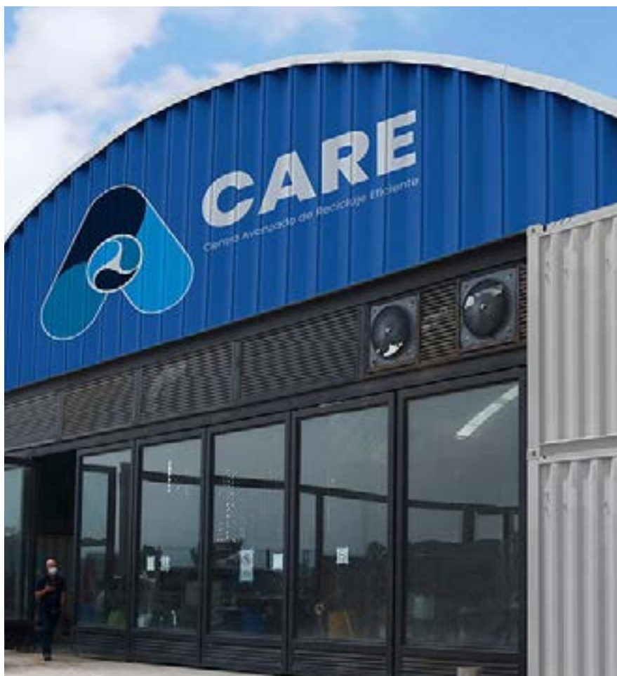
Primer lugar de economía circular. Centro Avanzado de Reciclaje Eficiente
