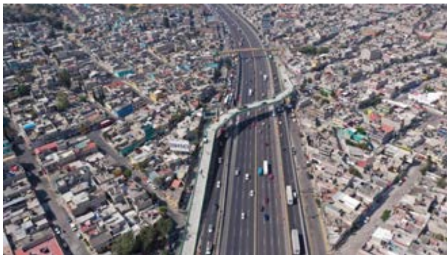
Sobse, puente vehicular Emiliano Zapata
