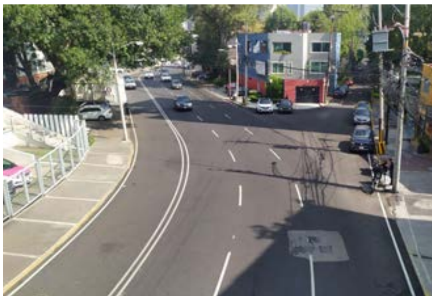
Sobse, repavimentación Eje 10
